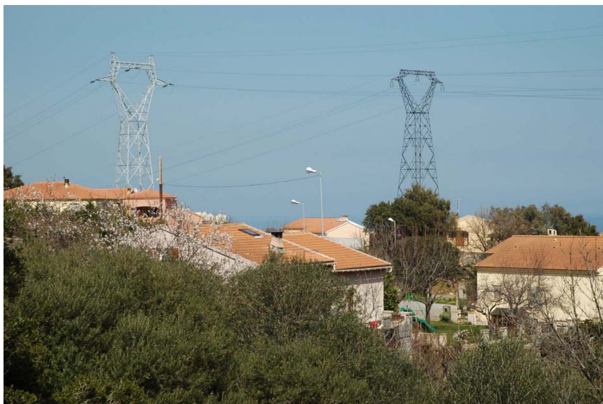
Ligne 90 000 Volts passant dans le lieu-dit « Chioselle » à Furiani
