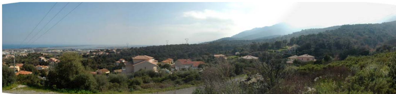
Vue panoramique du début des lignes électriques traversant les zones périurbaines de Furiani
