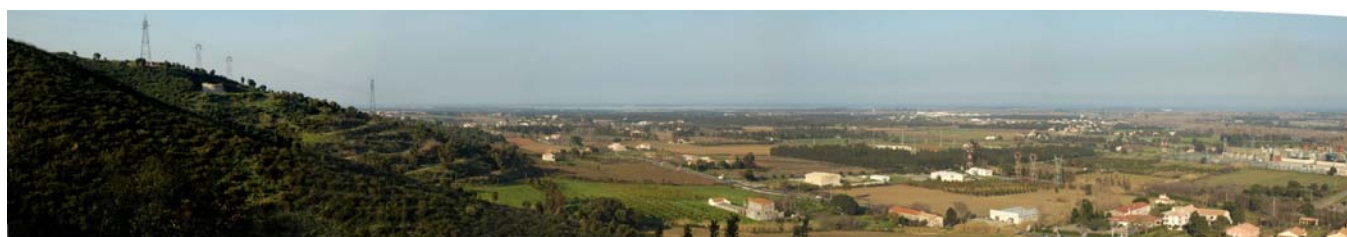
Vue panoramique de l'arrivée des lignes électriques au poste de Lucciana
