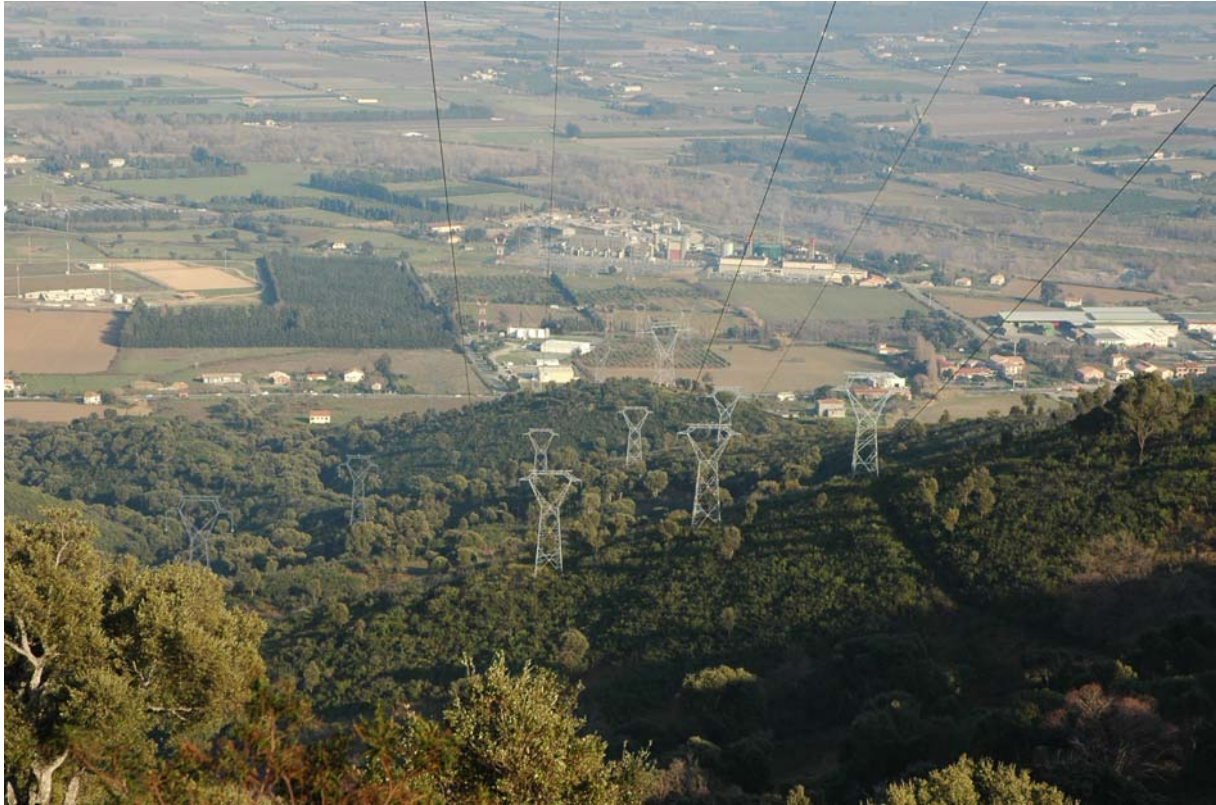
Arrivée des lignes électriques au poste de Lucciana, partie perpendiculaire à l'axe de migration
