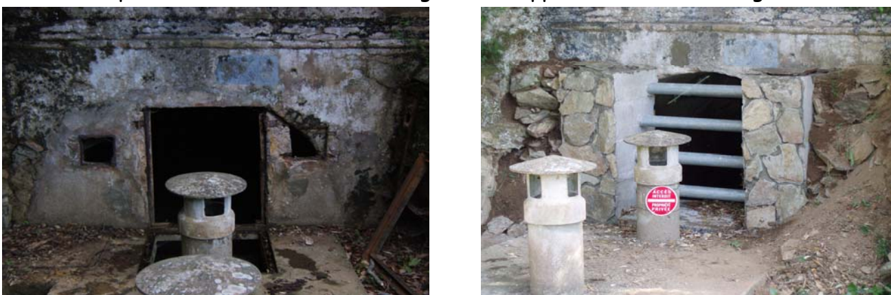
Figure 2 : Mine d'ERSA (à gauche avant travaux, à droite après travaux)
