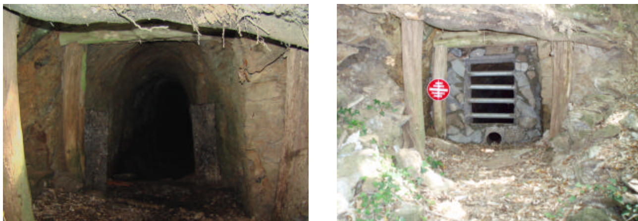
Figure 1 : Mine de LURI (à gauche avant travaux, à droite après travaux)
